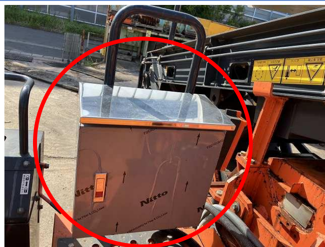
分電盤増設①(外)
