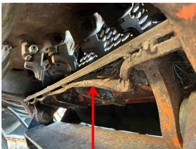
ウェアプレート異形品及び土台変形
