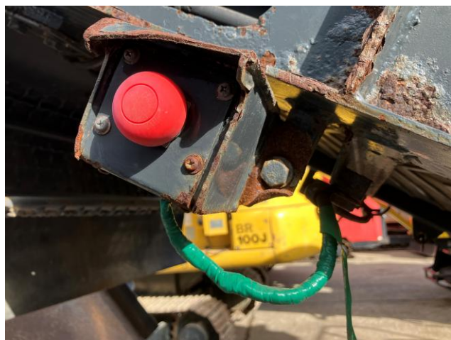
非常停止スイッチ故障配線修理
