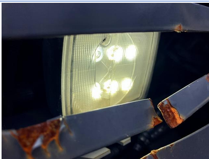
フロントライトレンズ割れ
