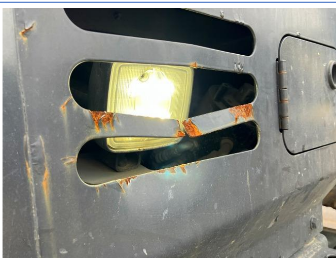
フロントライトカバー破損 ②
