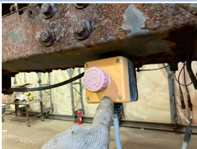
電装品不具合部(ホーン、非常停止ボタン等)点検修理
