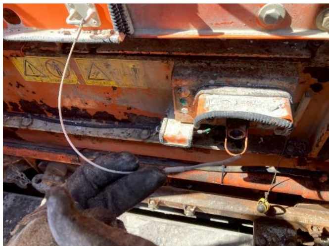
混合室安全装置不良修理
