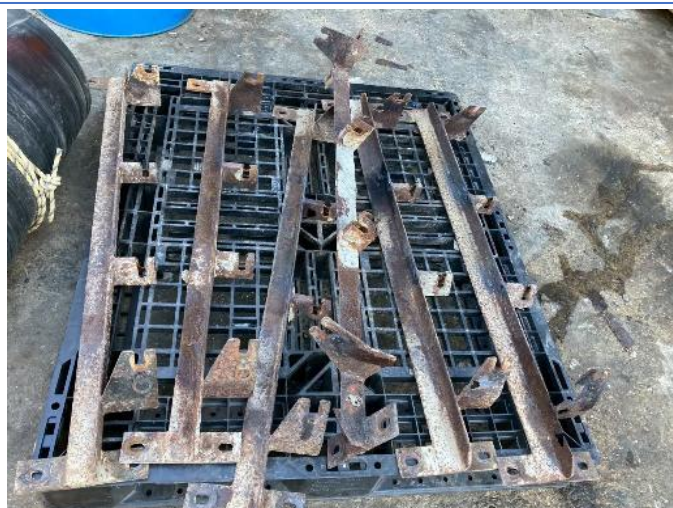
ブラケット類製作補修
