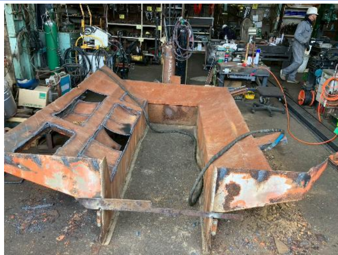
土砂ホッパー鋼板張替え①
