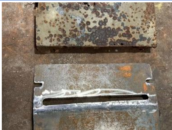
外装カバー製作交換箇所多数①
