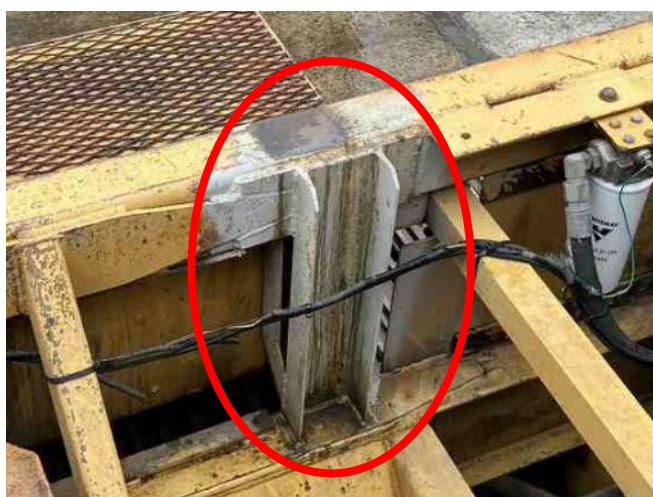
メインフレーム 加工補修痕あり
