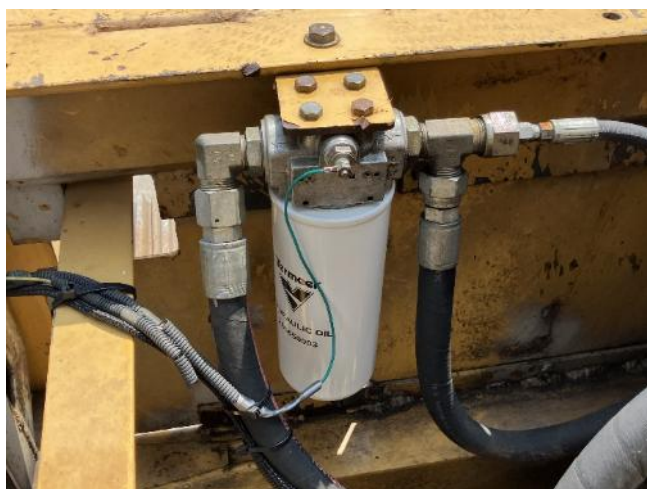
作動油エレメント 交換
